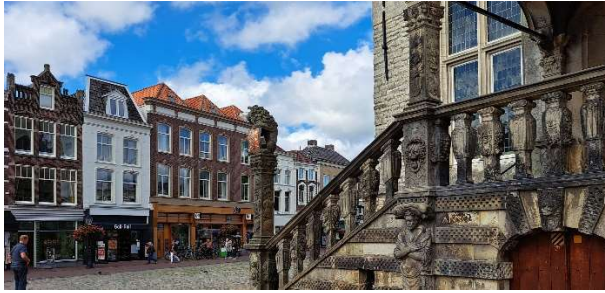
Afb.3. Herthuys (rood dak) september 2024. Eigen foto.
